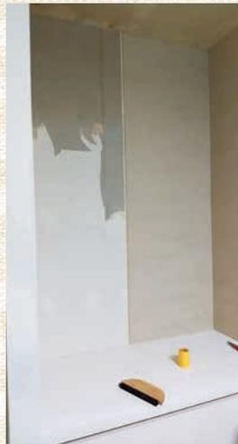
上級編に挑戦したいという思いにかられ、次の部屋へ。同じく絨毯をはがし床板を貼り、その上に置き畳を敷きます。さらに天井と壁の壁紙をいったん剥がし、張り直します。壁側は、事前にYouTubeを見ていたおかげで割と簡単にできました。一方、天井側は大苦戦。母と一緒に作業するのですが、ただでさえずっと上向きの作業で動きが悪いのに、張り付けたところから壁紙が重力に負けて落ちてくるのです。それでも何とか完成させましたが、二度と天井の壁紙の張り替えはしたくないです。
