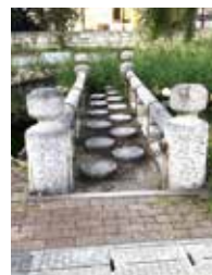
伏水街道第一橋
